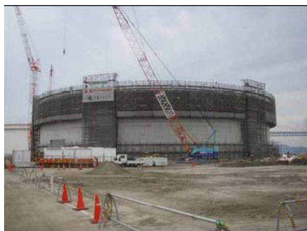
PC外槽式円筒形貯槽 遠景
