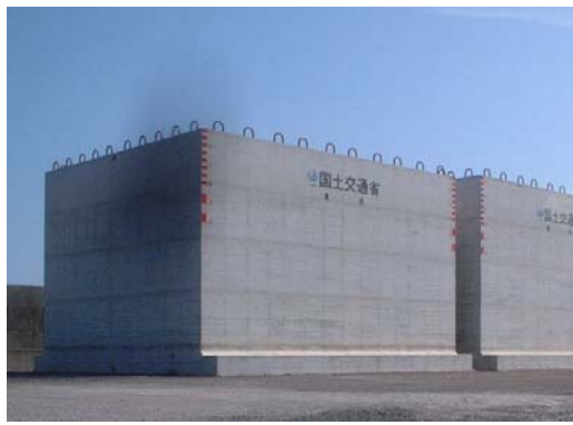
高知港三里地区防波堤工事 ケーソン製作状況
