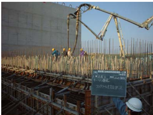
高知港三里地区防波堤工事 ケーソン製作状況
