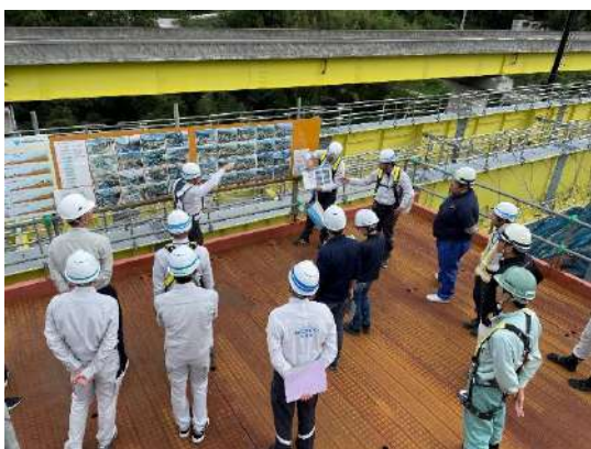
【上灘川橋 見学状況】
