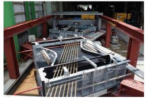
Fig. 6 Butterfly web fabrication
