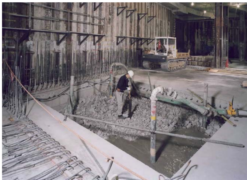
写真-1 カウンターウエイトの施工状況
