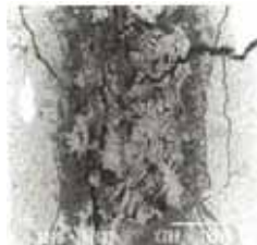
ひび割れを導入し15年間干満帯に暴露されたコンクリート供試体 (濱田委員提供)
