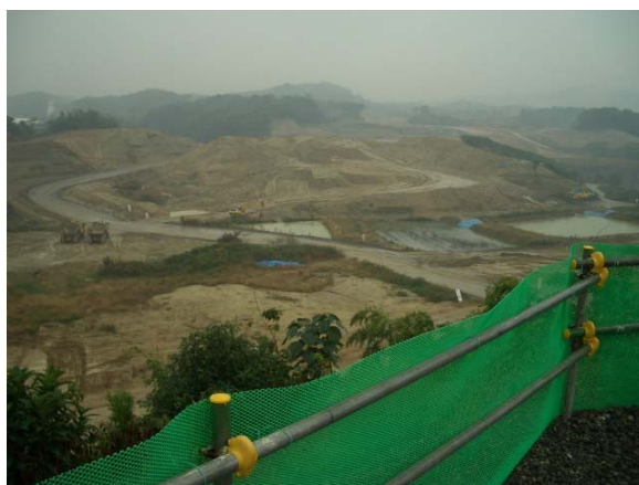
香川用水調整池建設現場
