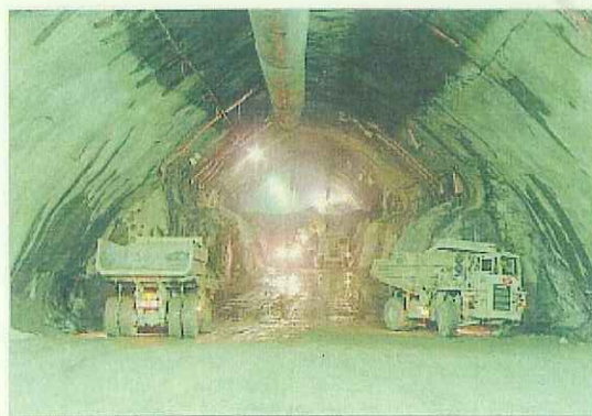
トンネル内（完成断面 幅26m 高30m）
