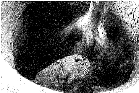
モルタルミキサーで練り混ぜ・手練り
